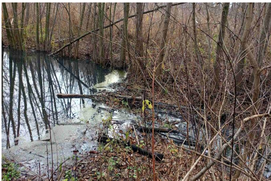
Рис.10. Плотина на 1-ом участке.
